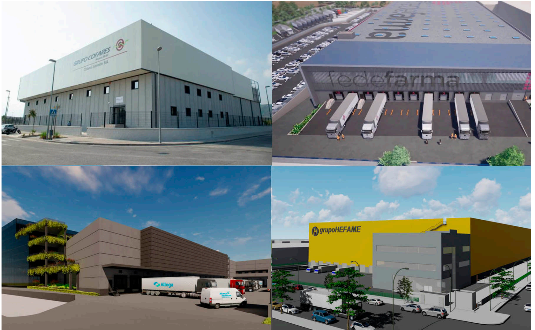
Imágenes —reales o virtuales— de diferentes almacenes edificados, o en proceso de construcción, de las principales entidades mayoristas de medicamentos en España.
